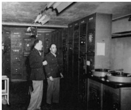
Figura 10. Instalación de Sigsaly. Cortesía National Security Agency.
